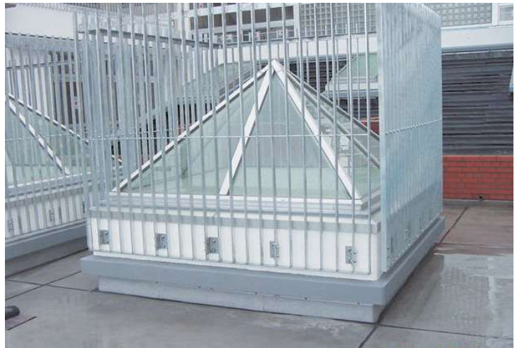
防護柵（別途）を設置した例
